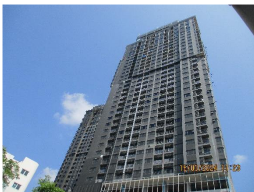
รูปที่ 22 ติดตั้งผ้าใบการก่อสร้าง (Mesh Sheet ชนิดกันไฟลุกลาม) คลุมอาคาร (เดือนมีนาคม พ.ศ.2567 โครงการได้รื้อถอนออกแล้ว)
