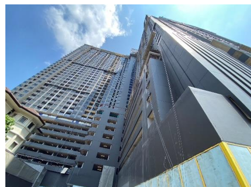
รูปที่ 22 ติดตั้งผ้าใบการก่อสร้าง (Mesh Sheet ชนิดกันไฟลุกลาม) คลุมอาคาร (เดือนมีนาคม พ.ศ.2567 โครงการได้รื้อถอนออกแล้ว)
