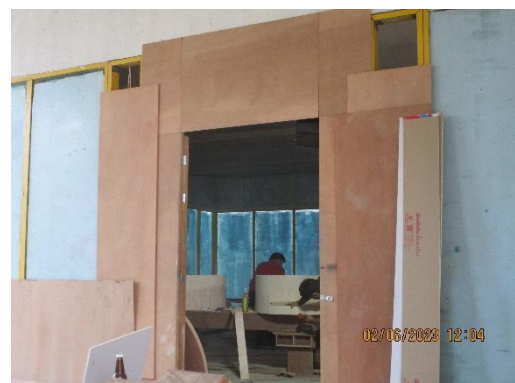
รูปที่ 23 ห้องเก็บเสียง และฝุ่นในการตัดเจียรกระเบื้อง
